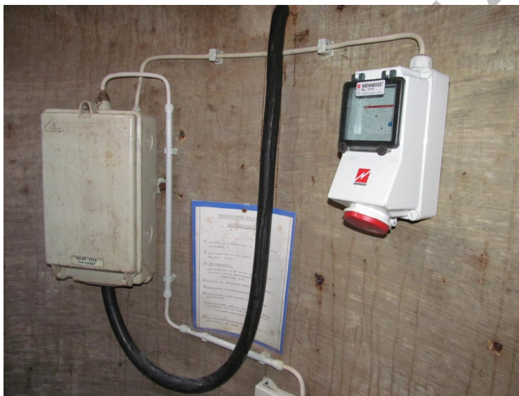
Abbildung 1 - Beispiel einer Direkteinspeisung ohne Zählung
