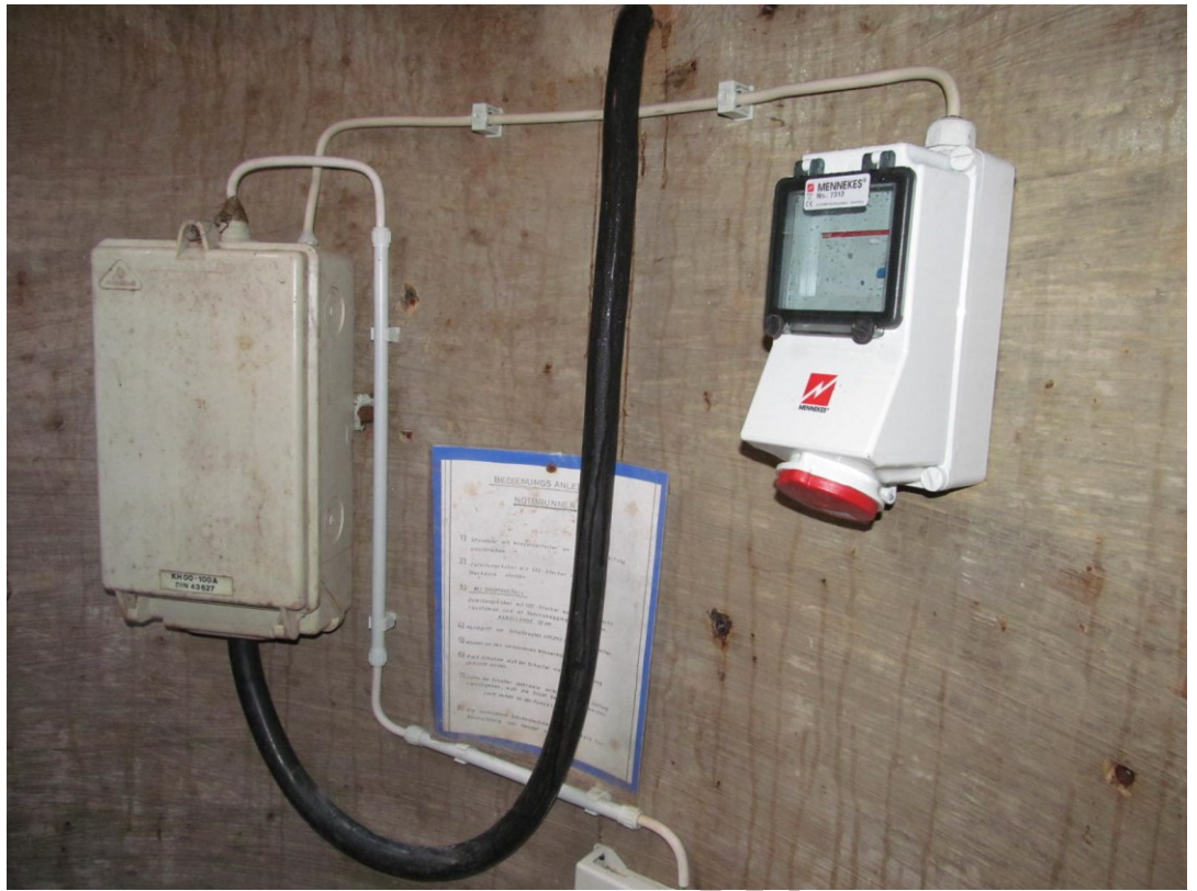
BALS Kombinierte Wandsteckdosen Nr.15078 IP67 bei Montage im Brunnenschacht
