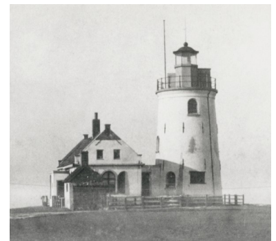
De vuurtoren in 1900. De torenschacht is nog niet verhoogd.
