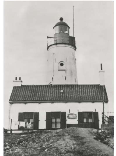
De lichtwachterswoning begin jaren '50.
