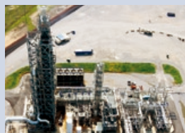
CO 2 回収実証プラント
