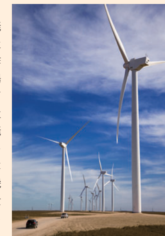
米国テキサス州 Penascalプロジェクト 2.4MW風車 (MWT92/2.4) × 84台
