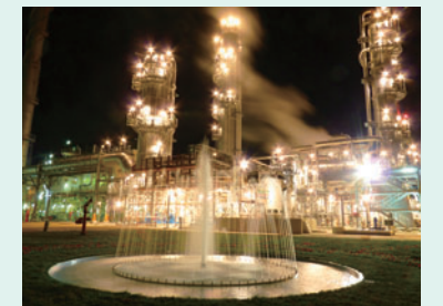
CO 2 回収装置
