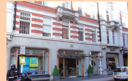
MPSE本社が入居しているビル
