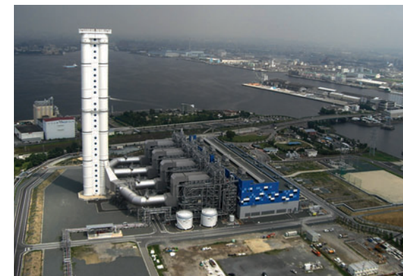
火力発電プラント (中部電力)
