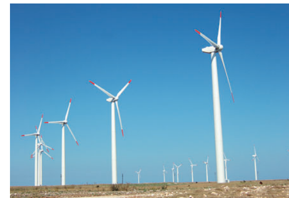
風力発電設備 (ブルガリア)
