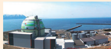
泊発電所3号機
