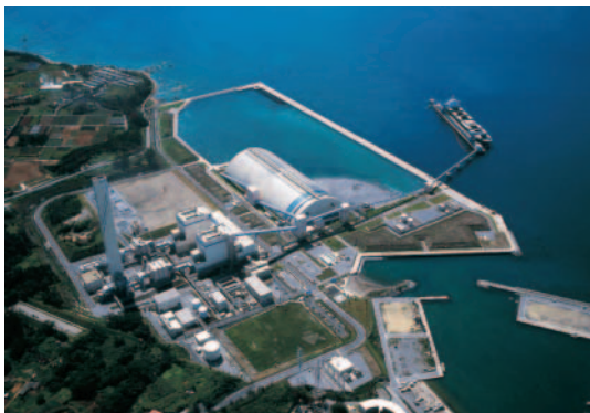
沖縄電力 金武火力発電所
