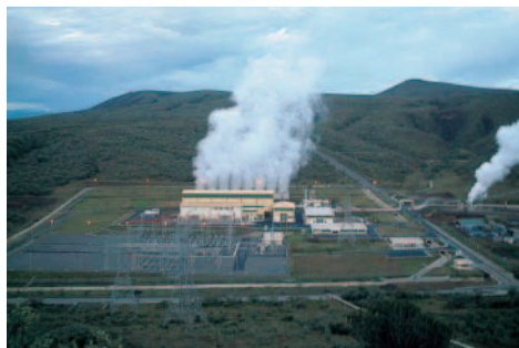
オルカリアII地熱発電プラント (ケニア)
