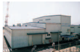
廃プラスチック圧縮梱包施設
