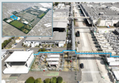
水素専焼エンジン発電セット実証設備
