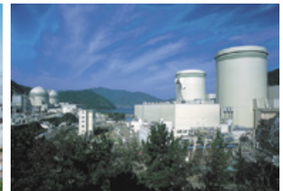
関西電力(株)高浜発電所
