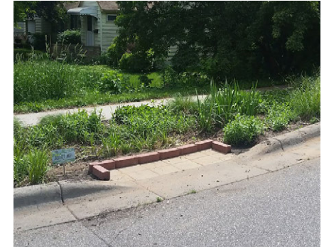
Shallow Sump Forebay (MSC WMO)
