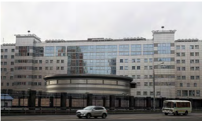
Gebäude des GRU
