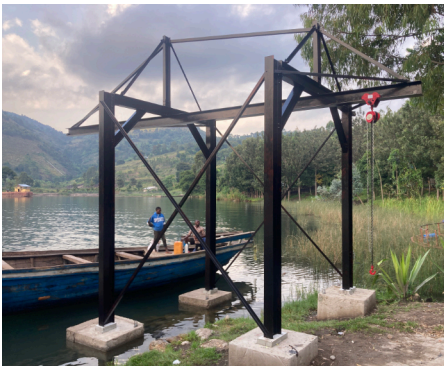
Boot unter dem neu erbauten Entladekran
