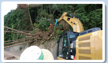
中国地方豪雨の復旧工事に協力
