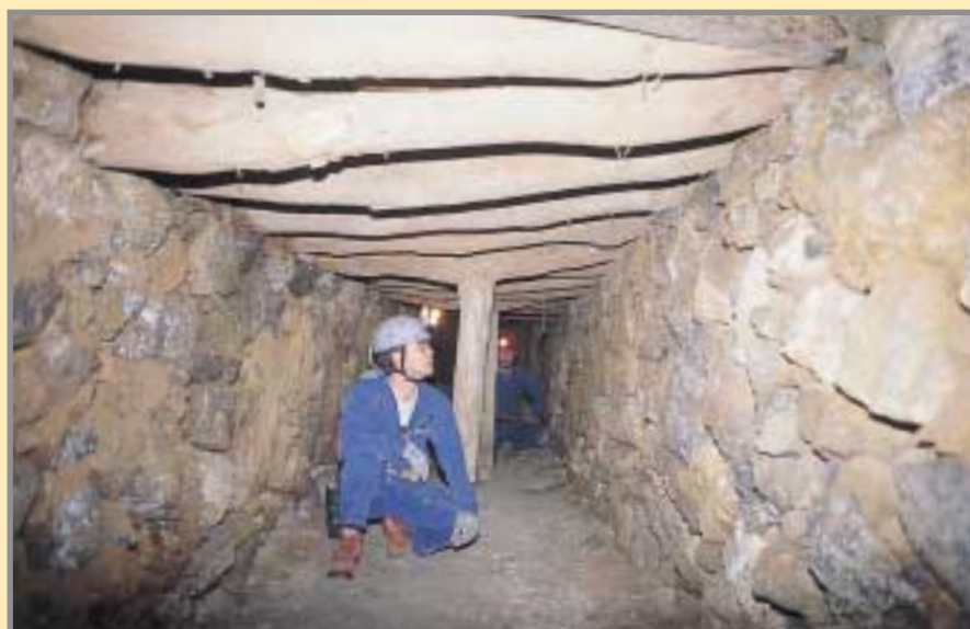
La belleza de sus labores mineras: Pasillo de pedriza y enmaderado en el socavón general.
