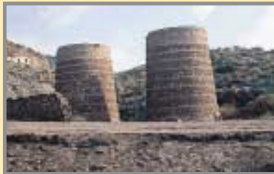
La siderita se calcinaba en estos hornos para su transformación a óxidos. Foto: Fernando Gómez.
