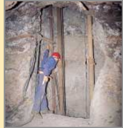
Enganche del pozo en el 2º piso. Foto: G. García.
