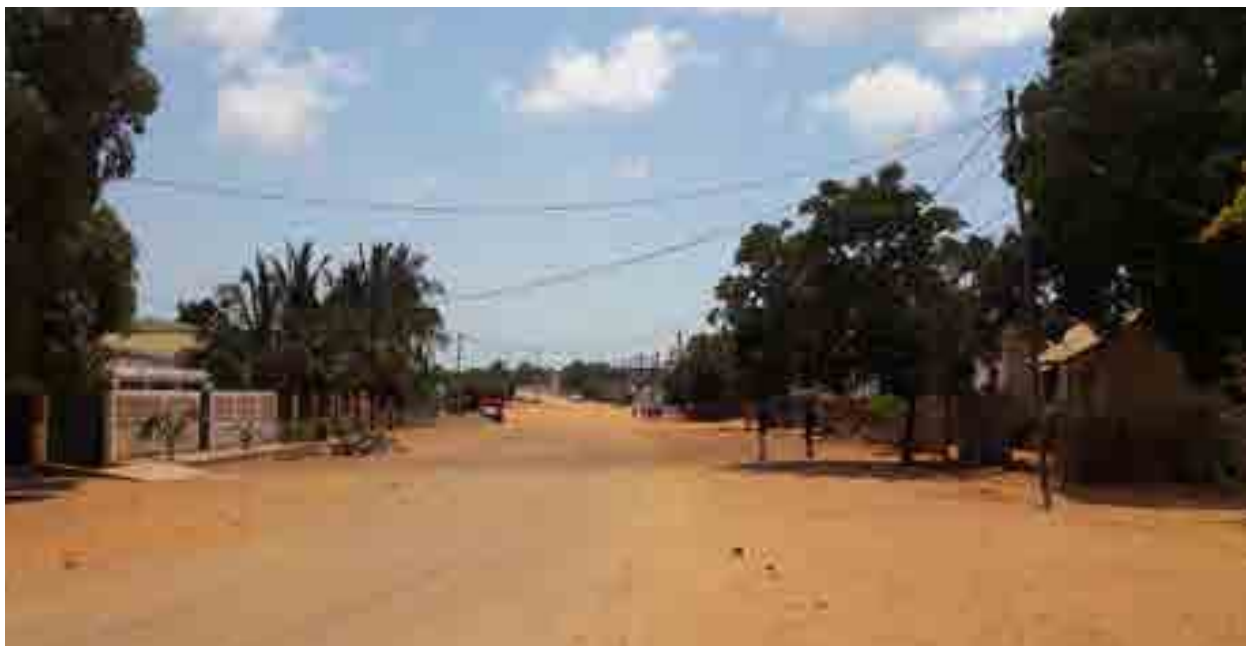
FIGURA 26. VIA PRINCIPAL EM PROJETO DO FFH COM ARGILA COMPACTADA
