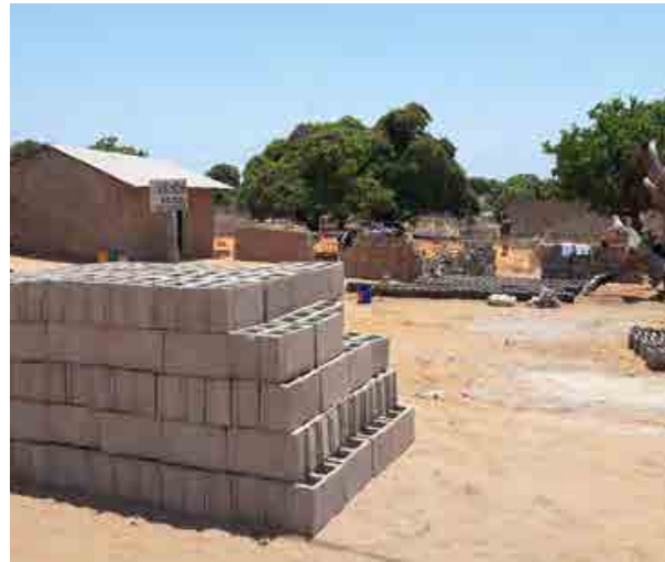
FIGURA 31. PRODUÇÃO INFORMAL DE BLOCOS DE CONCRETO, PEMBA
