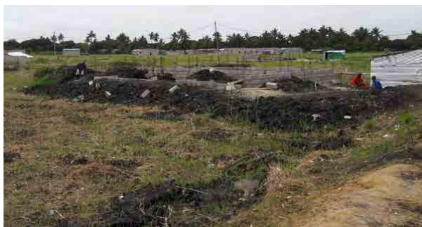
INSTALAÇÃO DE ATERRO ABAIXO DE CASAS COMO PREVENÇÃO CONTRA ENCHENTES, BEIRA. FONTE: EVANDRO HOLZ
