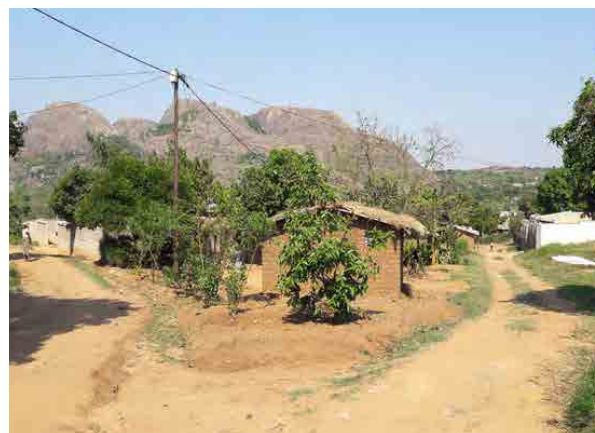
FIGURA 23. REDIMENSIONAMENTO DE VIAS DE ACESSO E INSTALAÇÃO DE DRENOS, BAIRRO JOSINA MACHEL, CHIMOIO
