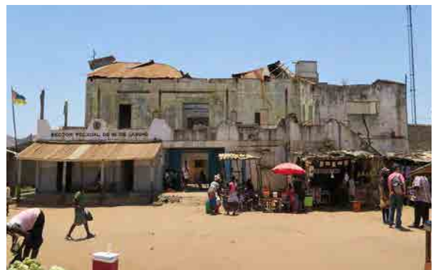
11.4. REUSO DE EDIFÍCIO ABANDONADO COMO POSTO FONTE: JOOST MÖHLMANN
