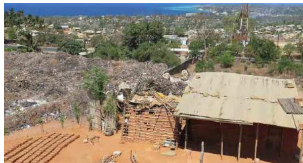
RETIRADA DE ARGILA PARA PRODUÇÃO DE BLOCOS DESESTABILIZANDO TALUDE, PEMBA. FONTE: EVANDRO HOLZ
