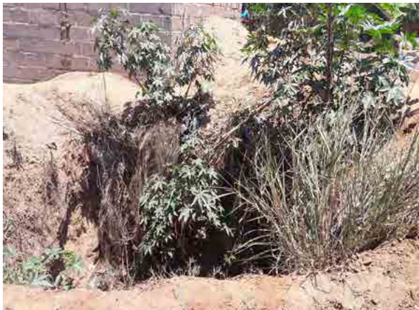
ESCAVAÇÃO DE FOSSA SÉPTICA INFORMAL, CHIMOIO. FONTE: EVANDRO HOLZ
