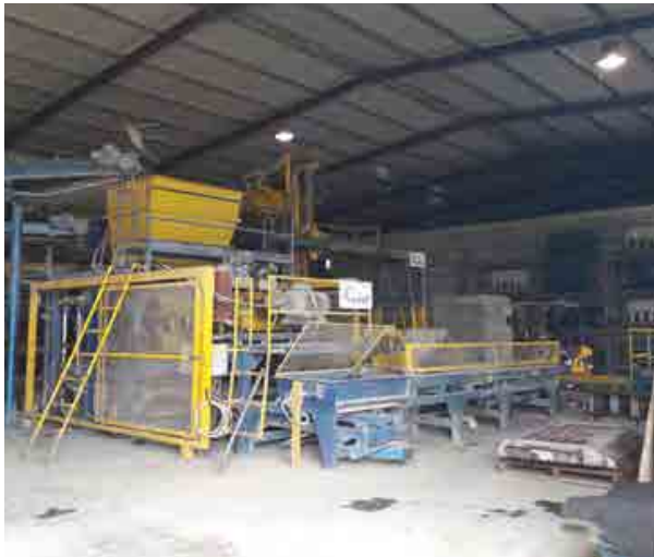
FIGURA 30. PRODUÇÃO FORMAL DE BLOCOS DE CONCRETO, BEIRA
