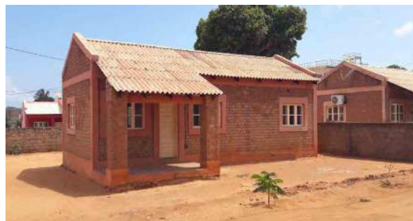
USO DE BLOCOS ECOLÓGICOS HIDRO-FORMA, PEMBA. FONTE: EVANDRO HOLZ
