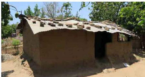
BLOCOS SEVINDO DE PESO PARA TELHADO. FONTE: JOOST MÖHLMANN
