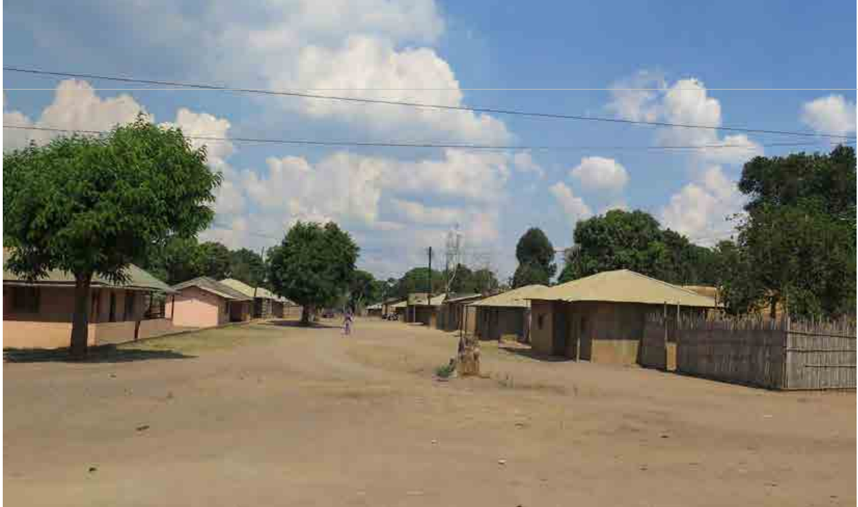
FIGURA 27. RUA COM ALINHAMENTO FEITO PELA COMUNIDADE, VILA DE MUEDA
