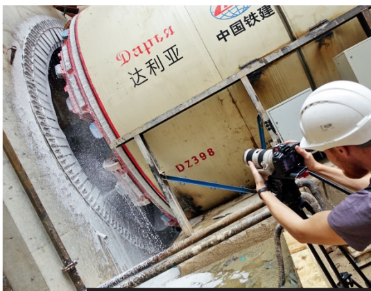
Строительство участка Третьего пересадочного контура московского метрополитена китайской строительной корпорацией China Railway Construction Corporation (CRCC).
