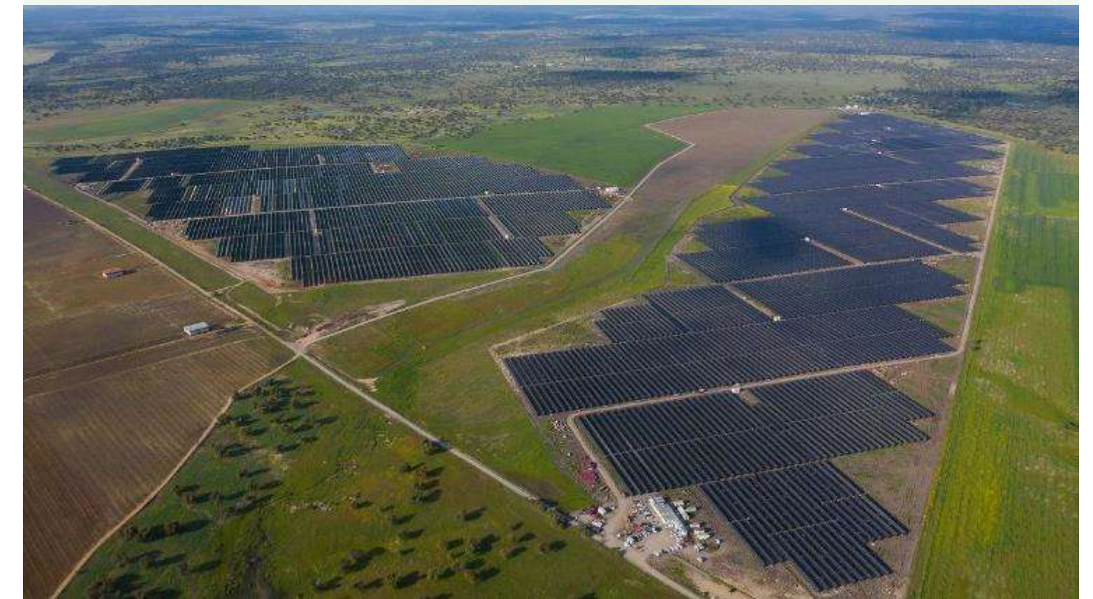
Proyecto fotovoltaico de 100MW en España
