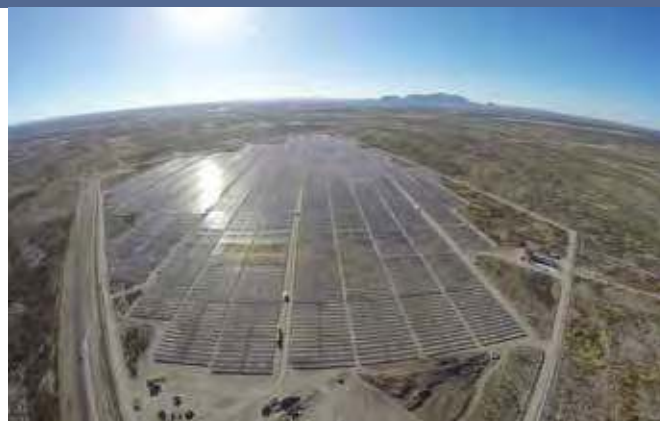
Fig. 1 - Camargo Solar Plant: Granja Solar Fotovoltaica Camargo, Chihuahua, Mexico; 35,5 MW (Photo: balamfund.com).
