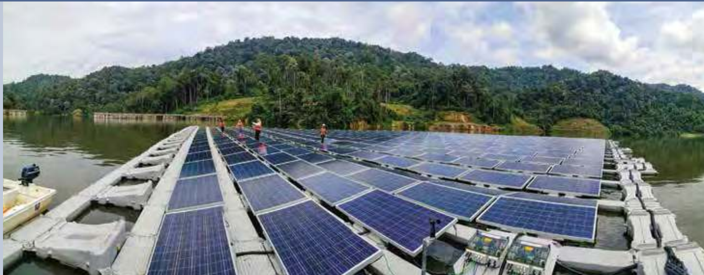
Fig. 1 - Floating PV System 270 kW, Rembau, Negeri Sembilan Darul Khusus (Photo: Sterling Fiesta Sdn Bhd).
