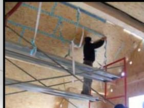
Préparation des caissons . Etanchéité à l'air
