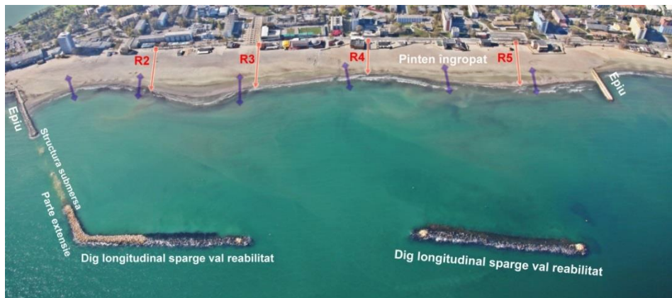
Figura II.1-4 - Măsurile de protecție costieră – sector Mamaia Sud
