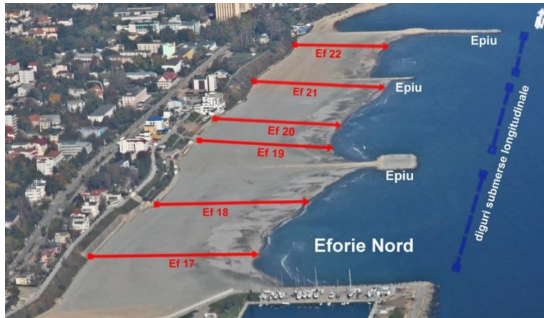
Figura II.1-7 - Măsurile de protecție costieră – sector Constanța
