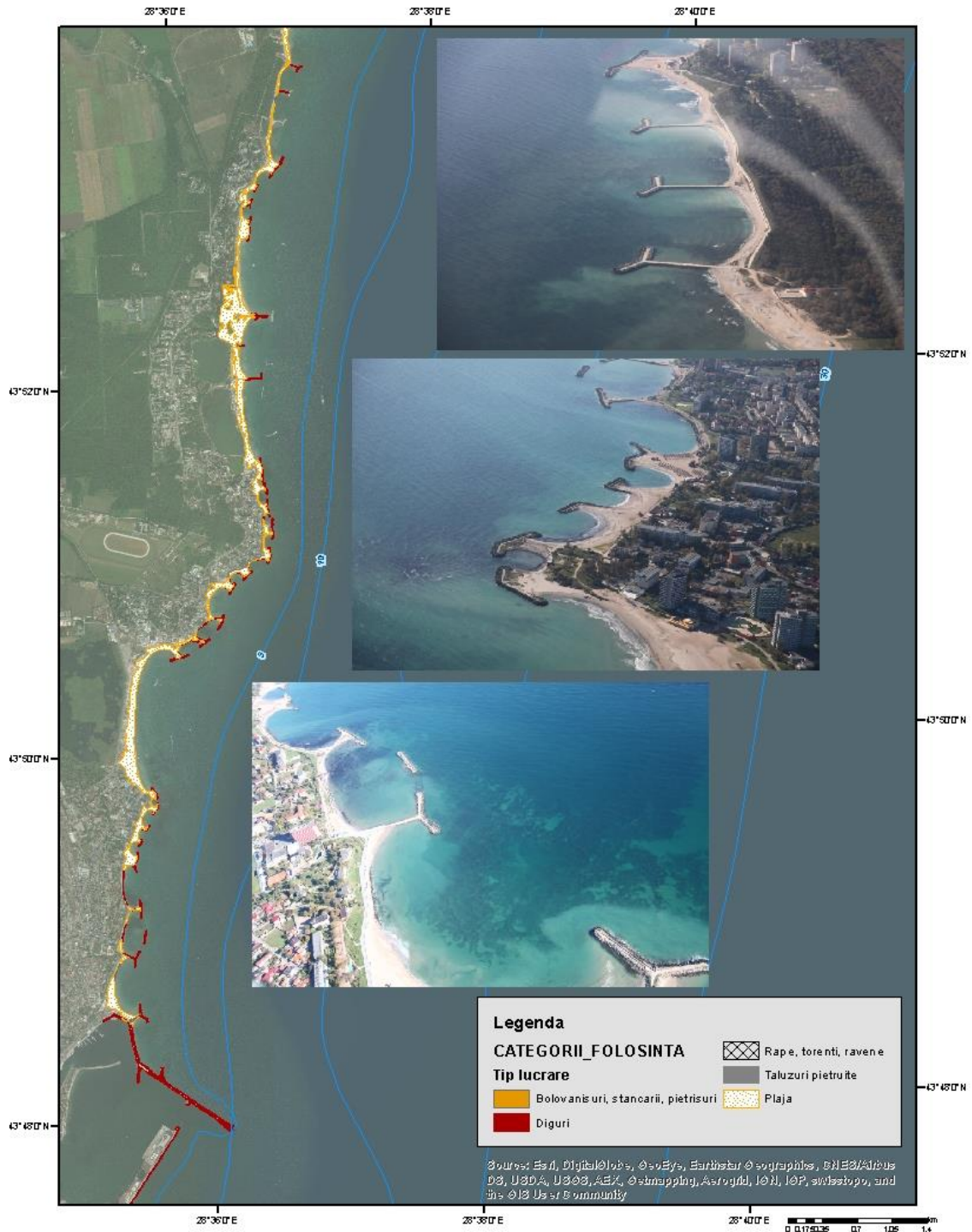
Figura II.1-3 - Structuri de protecție costieră (sector Olimpia- Mangalia)
