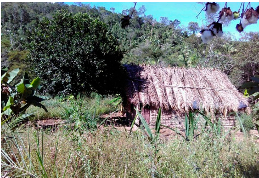
Figura 2: Cobertura de casa com palha do coco indaiá
