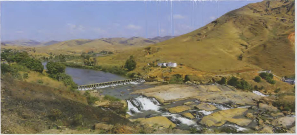
Photo 1 : Centrale hydraulique de la commune d'Andriba.
