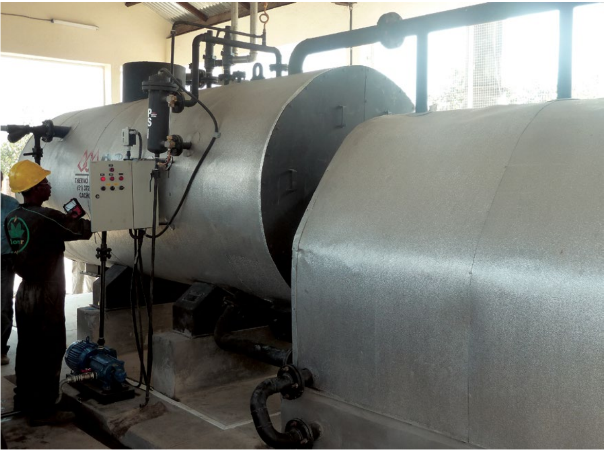
Photo 6 : Foyer et chaudière en phase d'installation sur le site de la commune rurale d'Andaingo en août 2012.
