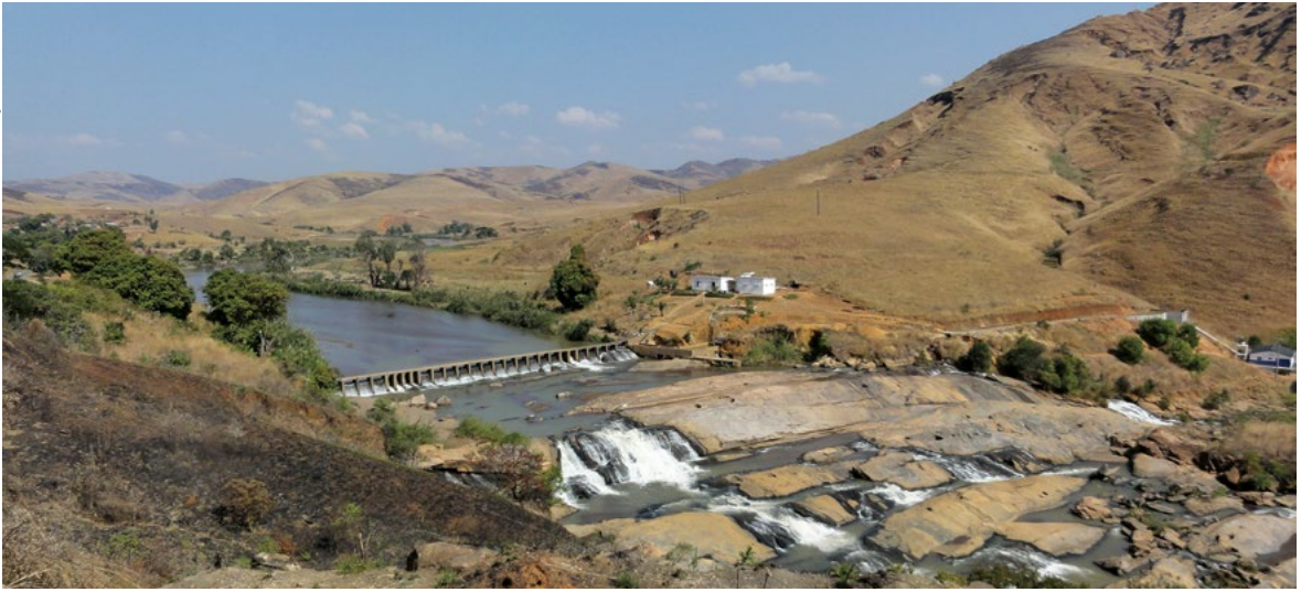
Photo 1 : Centrale hydraulique de la commune d'Andriba.
