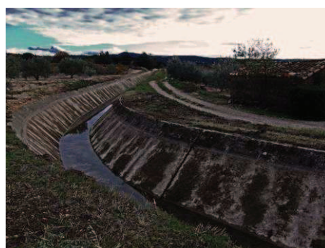
Canal d'irrigation à Aniane.
