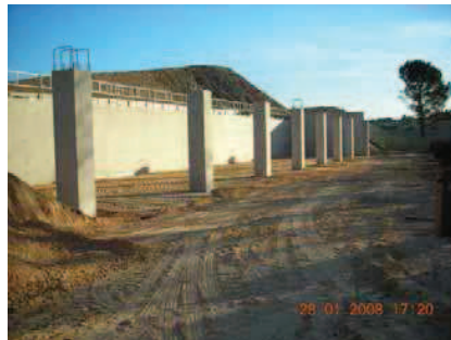
Voile béton et poteaux, Janvier 2008
