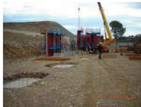
Coulage des murs enterrés, Janvier 2008
