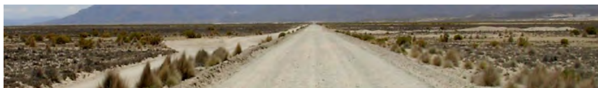
Vista de la carretera que comunica Uyuni con Pampa Aullagas
