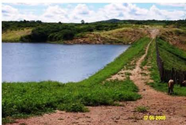
Figura II-9: Reservatório de L.Cercada.
