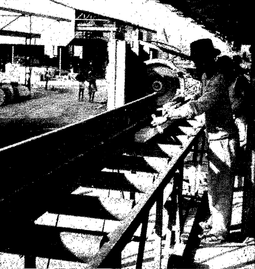
Tronçonneuse circulaire radiale. SCAF, Grand-Bassam, Côte-d'Ivoire, mai 1965.
