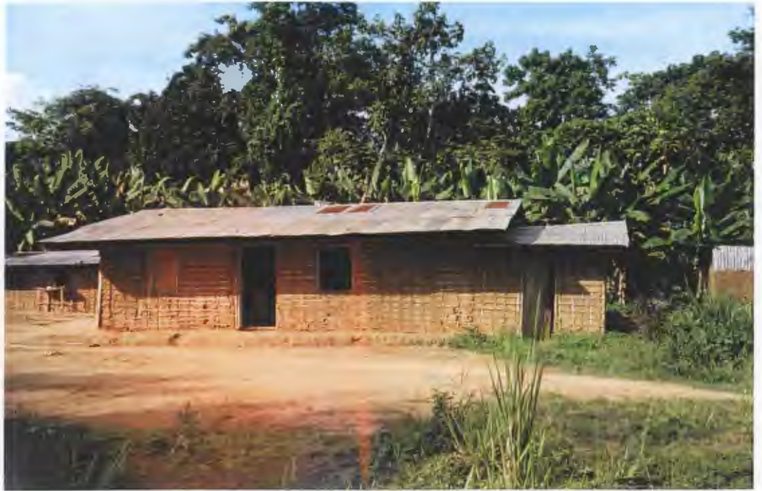
Maison d'un "grand" planteur de l'Ogooué-Ivindo: construction traditionnelle en terre battue mais avec toit de tôles ondulées.
