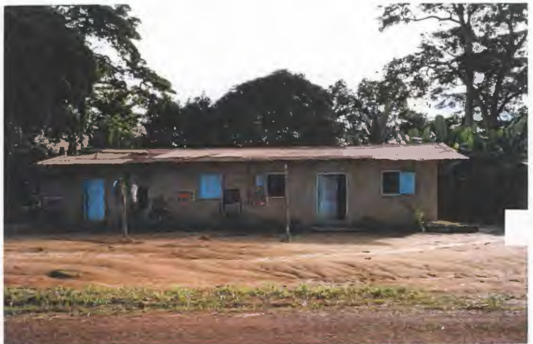
Maison d'un petit planteur du Woleu-N'tem : dalle et murs cimentés, toit de tôles ondulées
