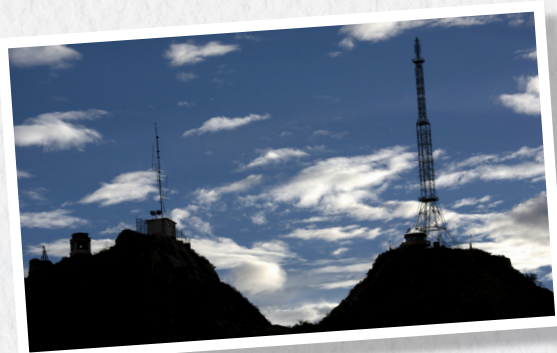
▲ 高原上的信号塔。刘铁军 摄 Signal tower upon the highland
