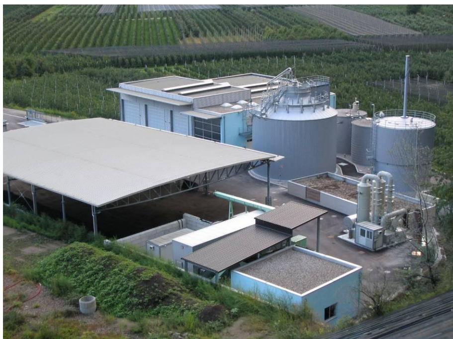
Figura 24: Foto dell'impianto di trattamento della FORSU di Lana.
