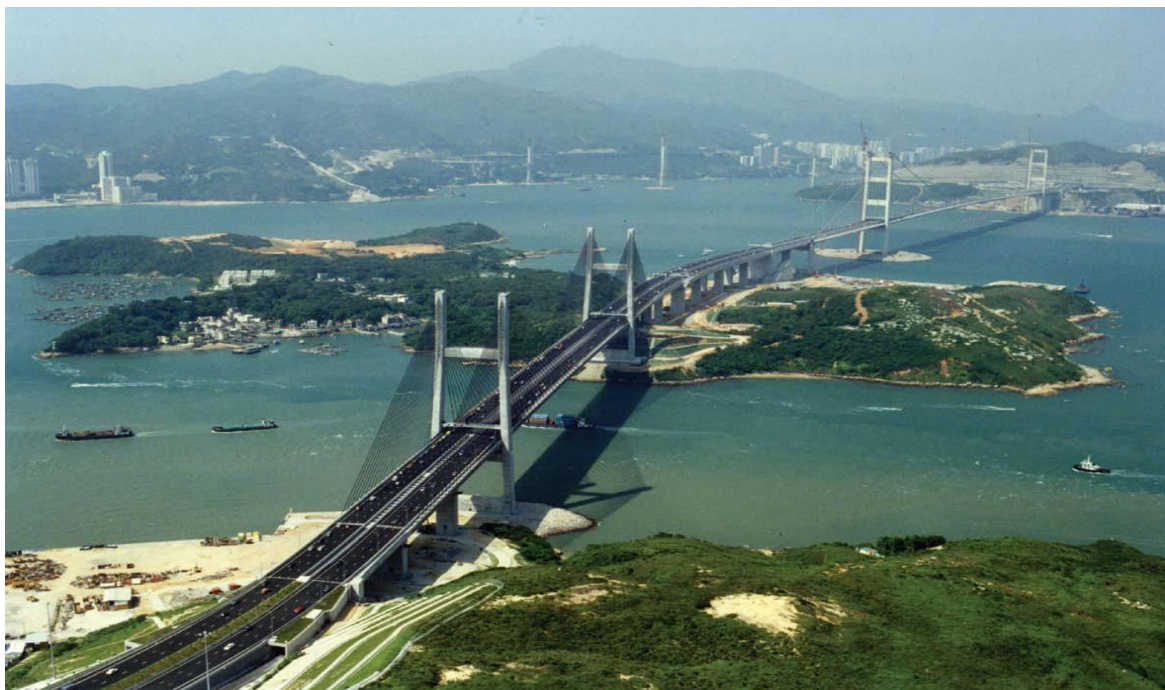
由青马大桥、汲水门大桥及马湾高架道路组成的香港青衣干线
