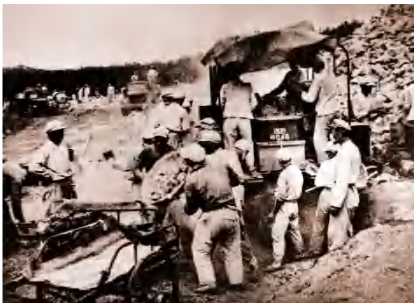
/ 工兵用国产碎石机碎石构筑坑道工事。
