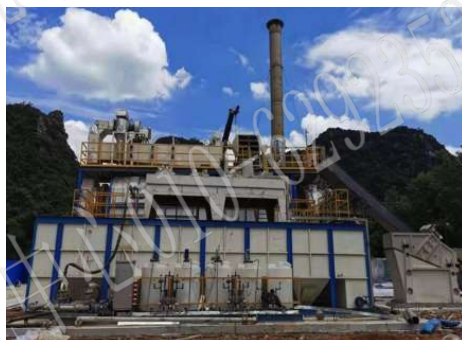
柳州造漆厂间接热脱附装置工程应用
