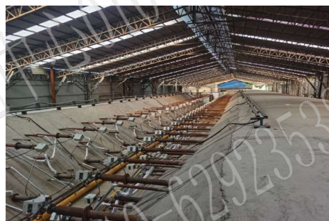
山东省临沂市某化工厂有机污染土壤修复工程
