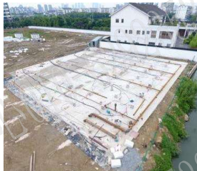
苏州溶剂厂电阻加热土壤修复中试现场
