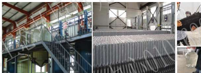
纳米羟基铝絮凝调理污泥处理处置工程项目
