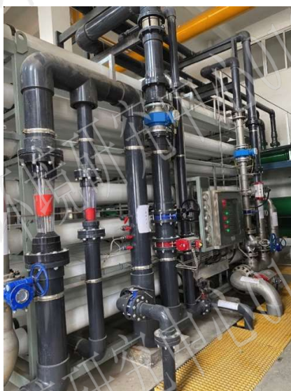
广东某电厂RO膜原位清洗修复
