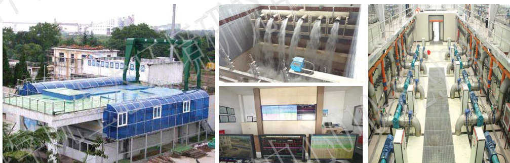
左图：江苏南通芦泾水厂（5万吨/天，全球首座超滤短流程水厂）；中图：北京309水厂（8万吨/天，稳定运行10天，全球最久，中上：水厂实物图；中下：智能控制系统）；右图：北京第九水厂（7万吨/天）
