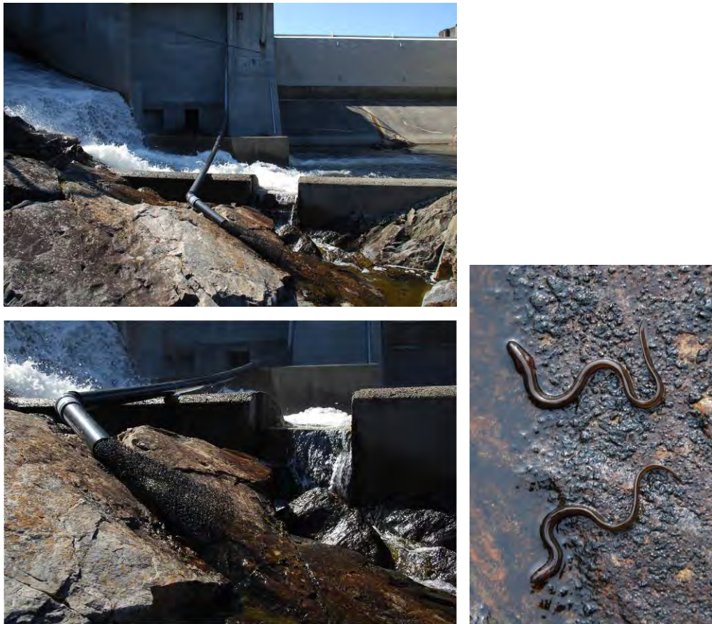
Figur 5.1. Åleleder i form av et rør fylt med enkamat ved Rygene dam i Nidelva i Arendalsvassdraget. Ålen finner veien opp det fuktige berget, og klatrer opp gjennom røret i enkamaten. Etter danske regler for åleledere, skulle åpningen på røret vært ført helt ned i vannet og ikke ligge åpent på berget. Effektiviteten av denne ålelederen er imidlertid ikke undersøkt, så hva som er beste løsning på dette stedet er ikke kjent. Det er observert ål på berget og på vei inn i røret. Foto: Dag Matzow.
